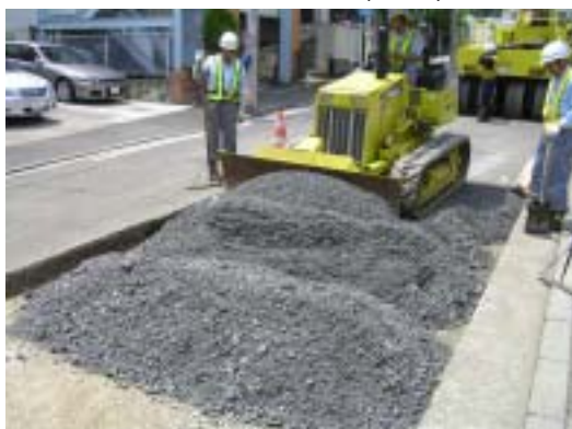
【保水性石炭灰路盤層(下層)設置】
