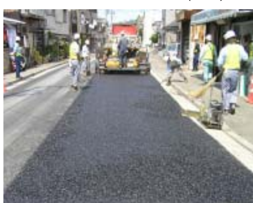
【保水性石炭灰アスファルト層(上層)設置】
