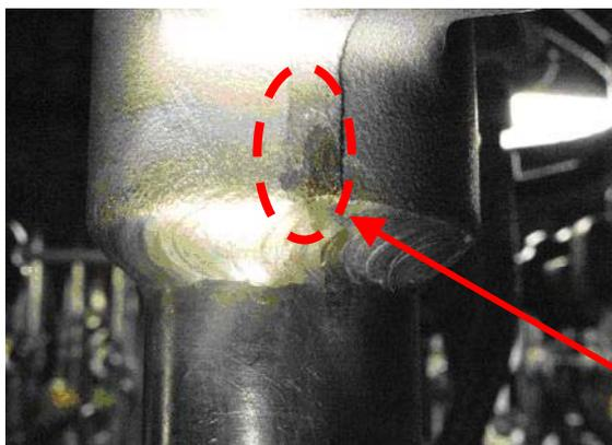
1号機は、水圧制御ユニットが 97 あり、にじみが発見された弁(101 弁) 2台は取り替え済み。101 弁の残りの 95 台と、同様の弁(102 弁)の 97 台、計 192 台が今後の取り替え対象。
