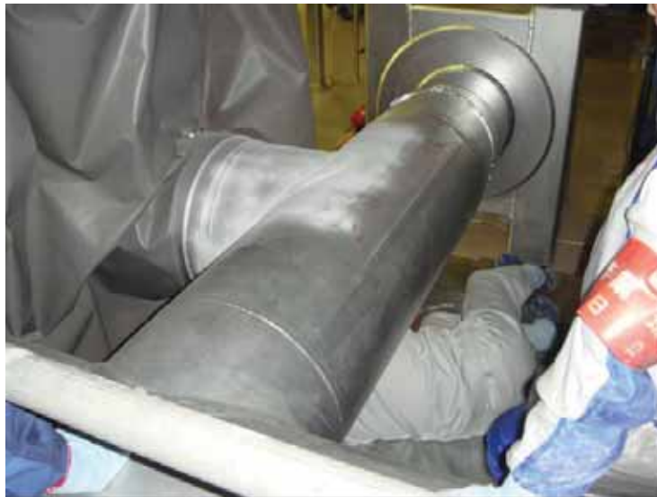
図-4 浸透探傷試験の実施状況
