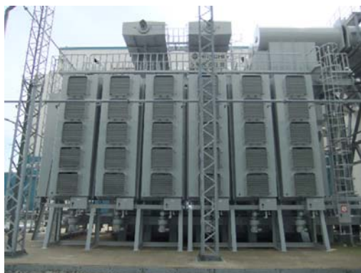
主変圧器の外観
