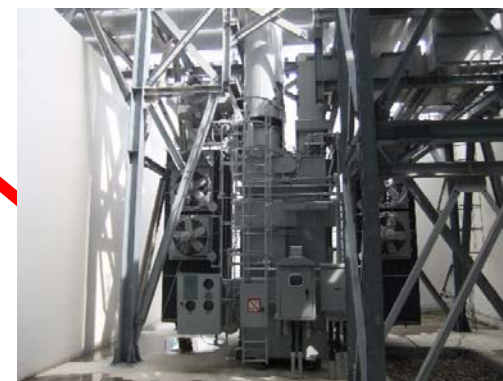
所内変圧器の外観
