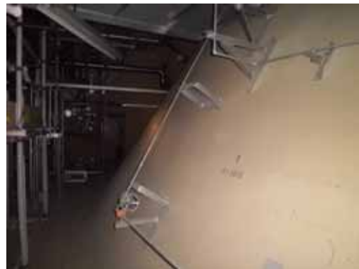
図-2.4 シェル壁の状況
