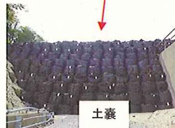
3月11日の地震・津波の際、津波が集中的に遡上した発電所南側海岸アクセス道路を土嚢及び盛土にて築堤を設置
