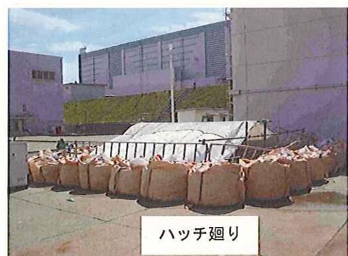
熱交換器建屋内への浸水を防止するために、扉・ハッチ廻りに土嚢を配備
