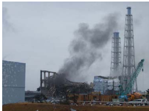
爆発後の3号機の外観
