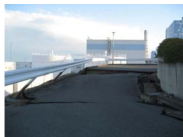
構内道路の状況
