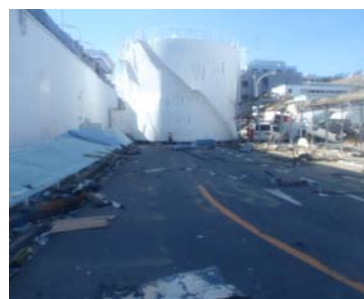
津波で流されたタンク
