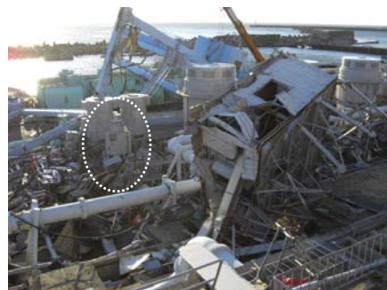
海水ポンプエリアの状況 (○内がDG（6A）海水ポンプ)
