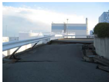
構内道路の状況
