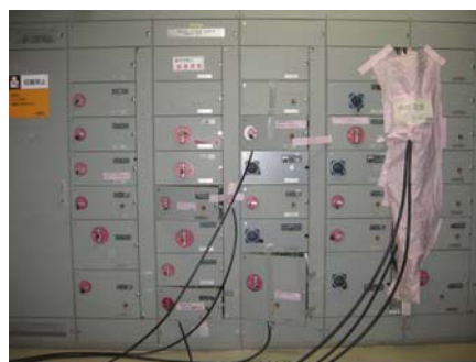
仮設電源ケーブルの接続状況 （写真は後日撮影のもの）
