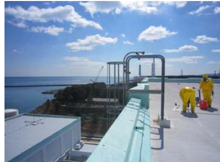
屋上での作業状況
