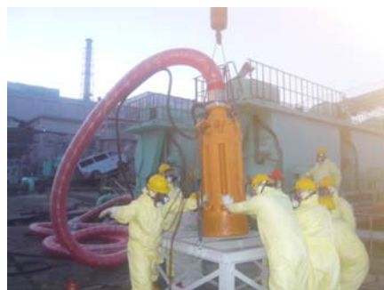
水中ポンプ設置作業の状況
