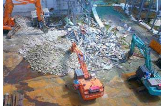
4号機周り支障物解体
