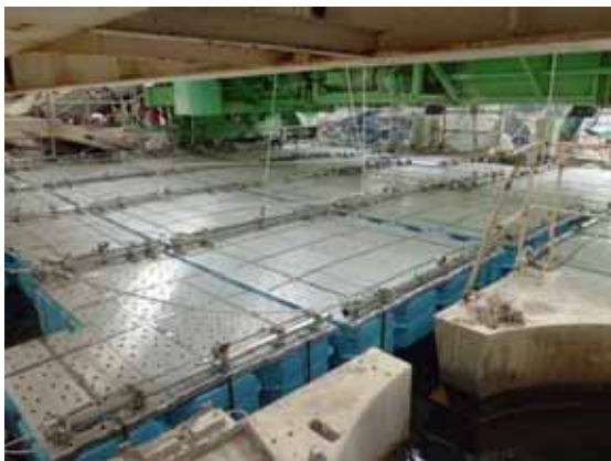
燃料プール養生
