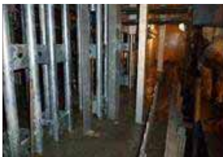
コンクリート打設状況(7/21撮影)
