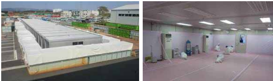
現場休憩施設外観(左)と内観(右)
