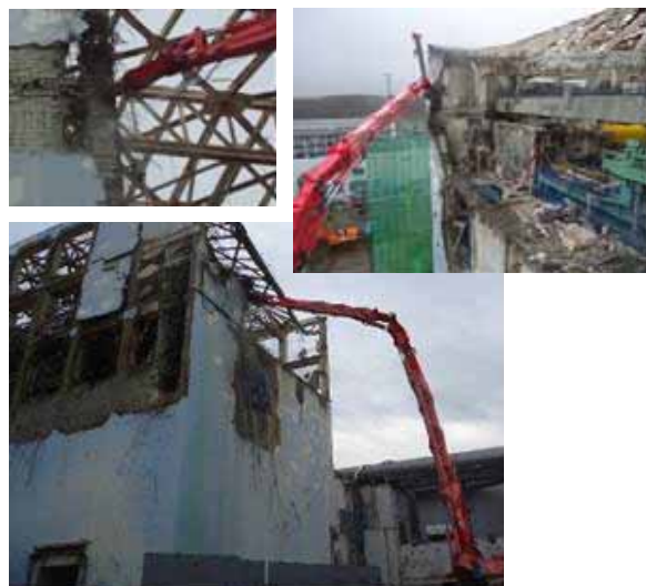
建屋上部瓦礫撤去
