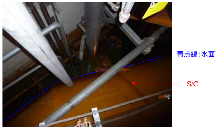
図 1-10 4号機トラス室キャットウォークから真下を撮影
