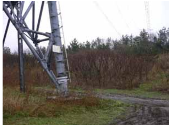
盛土高：約 8 m、鉄塔脚離隔：約 1.4 m
