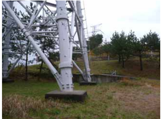
盛土高：約 1.2 m、鉄塔脚離隔：約 6 m
