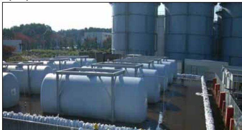
(2) 「野鳥の森」危険物屋外貯蔵タンクの外観
