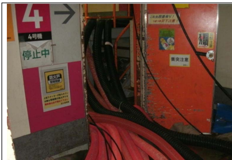
図5 4号機タービン建屋1階通路の耐圧ホース敷設状況
