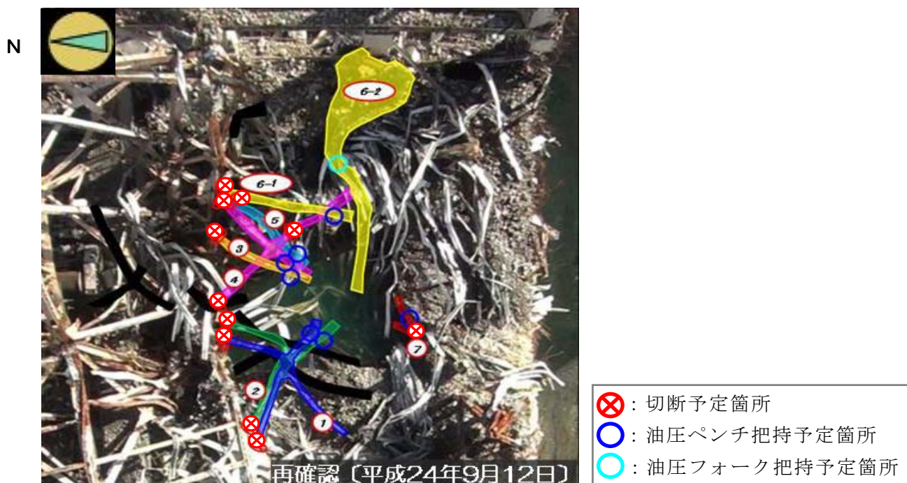
図-2 平成24年9月12日 鉄骨がれき撤去変更手順①
