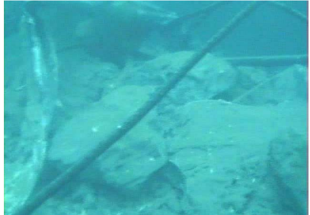
⑥使用済燃料貯蔵プール内の状況
