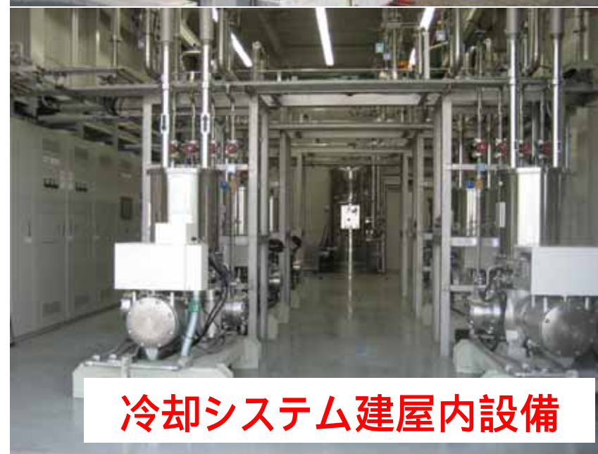
冷却システム建屋
