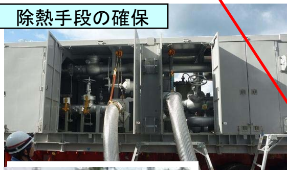
代替高圧注水設備設置
