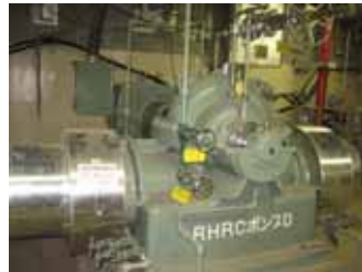
本設備復旧された冷却系ポンプ
