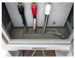
現場調査状況の例:変圧器内部の点検を行った結果、ケーブル入線部(写真右)に開口部の未処理を確認したため、閉止処置を実施
