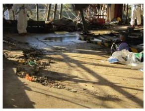
4号機原子炉建屋4階床の状況調査 床面が下方向へ凹んでおり爆発が4階で発 生したと推定(2011年11月10日)
