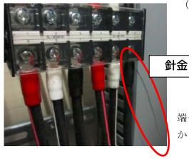
端子部 (アクリルカバーあり) の下部の隙間 から針金先端が端子台に入り込み、地絡発生
