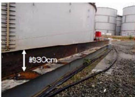
写真1 鋼製板による堰の設置状況(H4北エリア)
