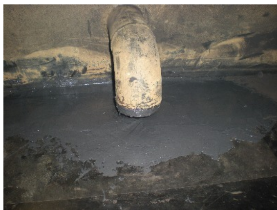
底板ドレン配管近傍
