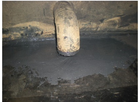
底板ドレン配管近傍
