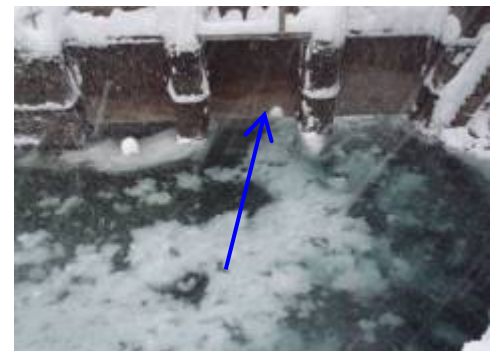
②沈砂池上流の側方ゲートを通過するスノージャム
