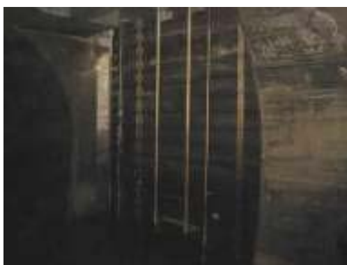
26号横坑の角落としには損傷がなかった (導水路内部で上流から撮影)
