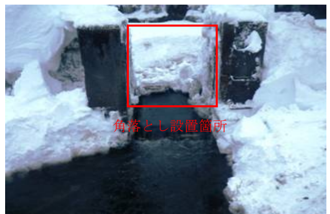
角落とし撤去後の状況 (調整池側から撮影)
