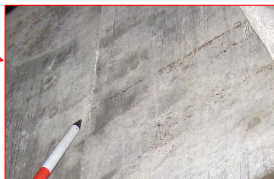
水面が角落とし天端よりも29cm高い位置まで上昇 (導水路内部から撮影)
