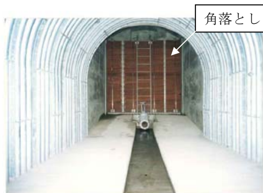
26 号横坑状況写真（事故以前に撮影）
