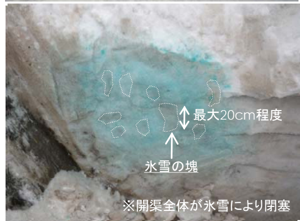
開渠に堆積したスノージャムの調査
