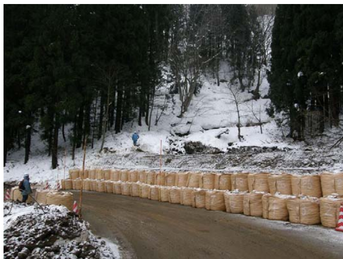
国道 405 号線応急復旧後
