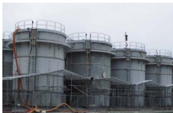
改善状況②：タンク堰カバー 設置後のフランジ型タンク
