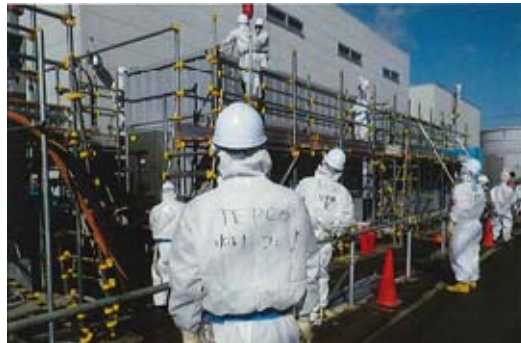
モバイル型ストロンチウム除去装置設置工事（福島第一）
