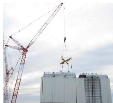
建屋カバー復旧状況
