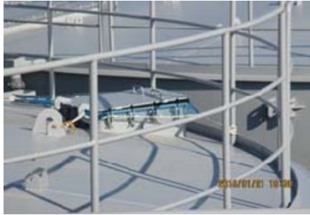
落下しない構造としたタンクの蓋 (福島第一)
