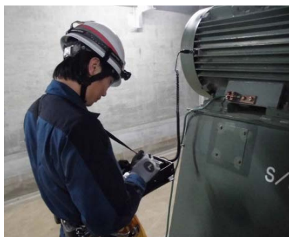
運転員の直営によるデータ採取（電動機の振動診断）
