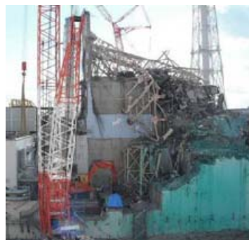
大型がれき撤去前の原子炉建屋
