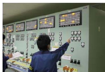
訓練中の中央制御室
