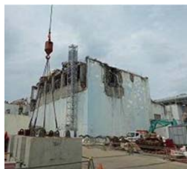
がれき撤去後の原子炉建屋
