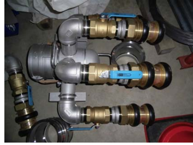
原子炉等への注水のための消防ホース接続用治具の配備（柏崎刈羽）
