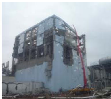
コンクリートポンプ車による 事故直後の燃料プールへの注水
