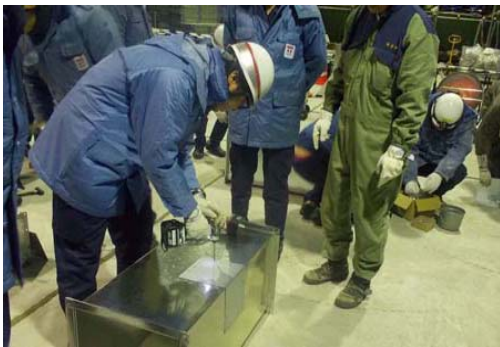
柏崎刈羽における空調ダクト応急修理訓練 (左：亀裂箇所へ補強板取り付け、右：補強板周囲を補修テープで気密処理)
