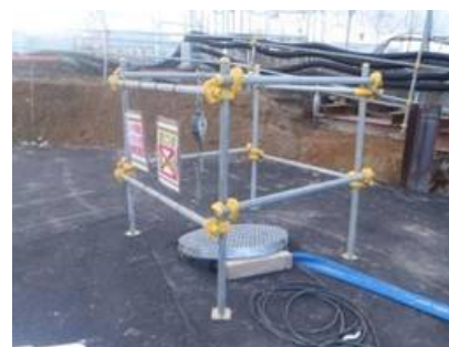
是正後(開口部にバリケードを設置)
