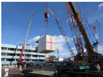
測定装置設置状況
