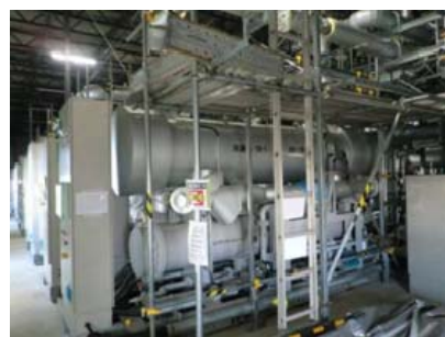
凍土用の冷凍機
