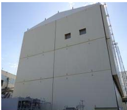
建屋カバー設置状況
