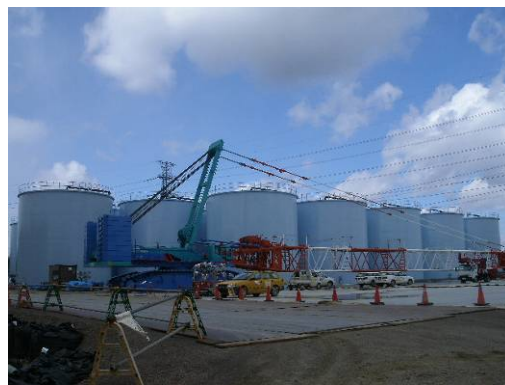
改善状況①：H1 エリアに 設置した溶接型タンク
