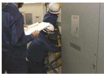
電源盤へのケーブル接続
