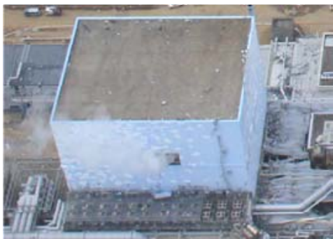
ブローアウトパネルが開放している 事故直後の原子炉建屋
