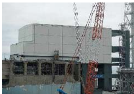
燃料取出し用カバーを設置後の 原子炉建屋
