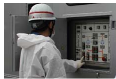
電源車の起動
