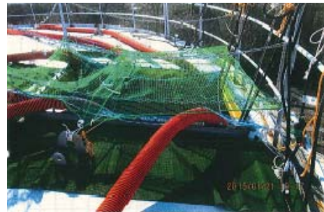
ハッチ開口部の落下防止対策 (福島第一)
