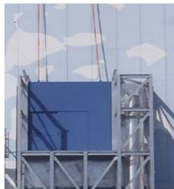
閉止したブローアウトパネル の開口部
