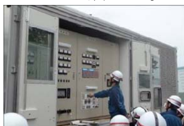
ガスタービン発電機車の起動試験
