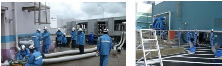
代替熱交換器車の接続訓練
