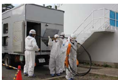
電源車からのケーブルの引き出し
