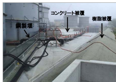
改善状況③：フランジ型タンク 堰の二重化・堰内塗装の状況
