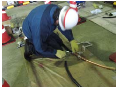
柏崎刈羽における低圧、高圧ケーブル末端処理訓練 (左：低圧ケーブルのシース剥がし、右：高圧ケーブルのシース剥がし)
