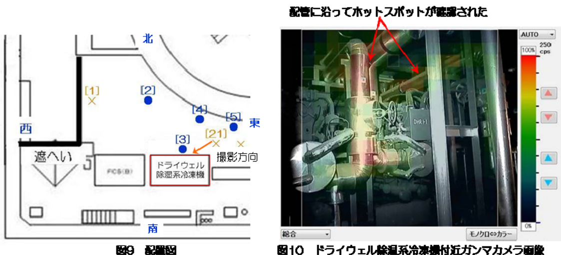
(原子炉建屋1階ドライウェル除湿系配管のガンマカメラ測定結果)
