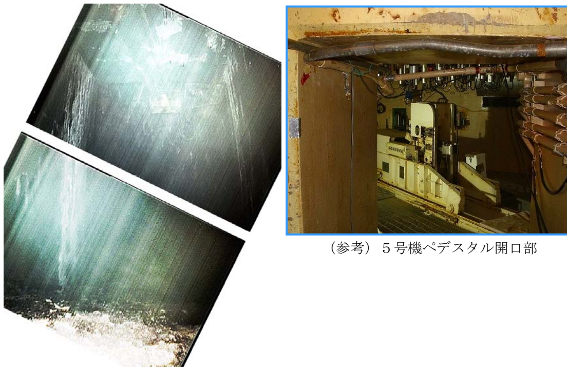
図 3-3 ペDESTAL 開口部からのペDESTAL 内部の画像 (画像処理後)
