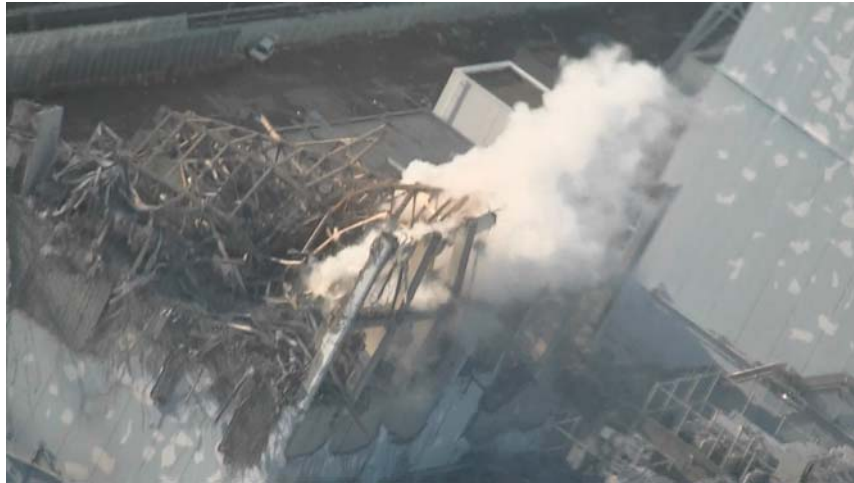
図 12 3号機空撮写真 (2011年3月16日撮影)
