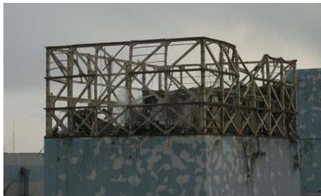
図 1号機原子炉建屋の外観写真
