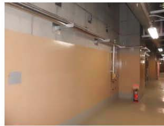
2階 (撮影日: 平成24年12月9日)
