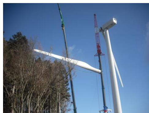
ブレード組立
