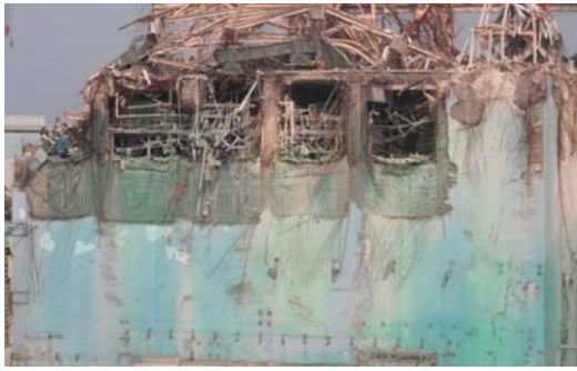
②東側壁面
