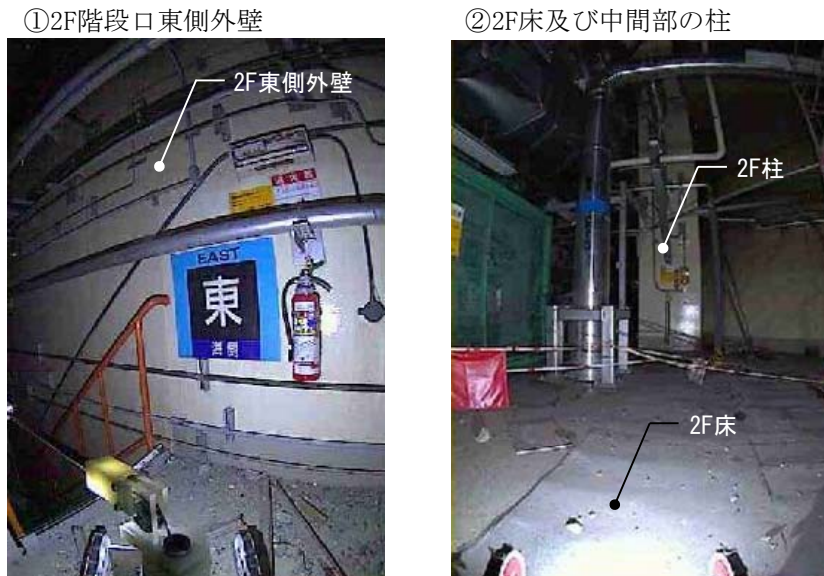
図-2.4(1) 建屋内状況写真（2階）
