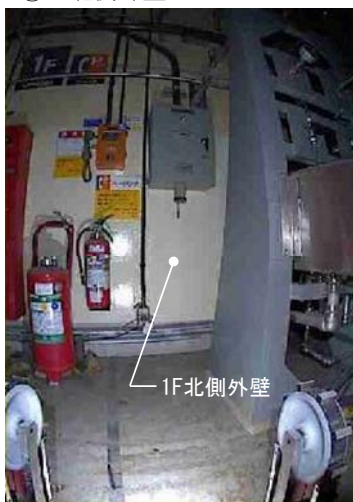
①1F北側外壁
