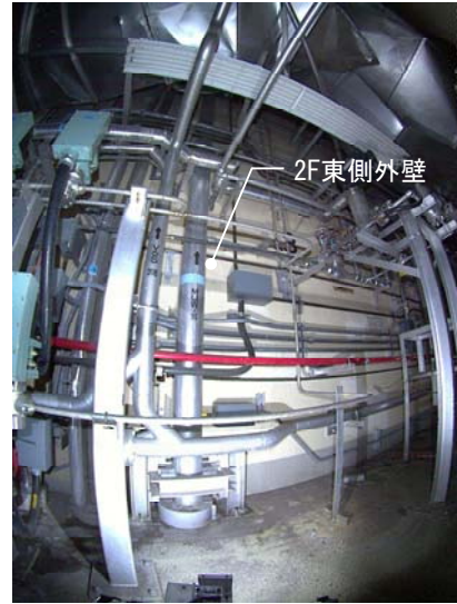
④2F東側外壁
