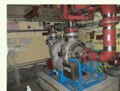
高圧代替注水設備を追設し原子炉注水機能を多重化
