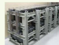
直流125V蓄電池等を追設し、従前の3倍以上（24時間以上）の直流電源容量を確保
