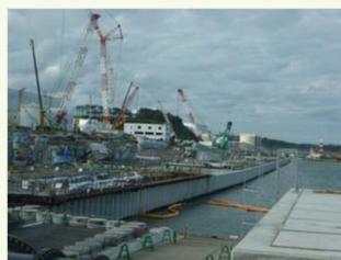
海側遮水壁矢板打設作業の再開
