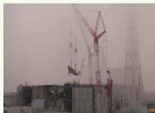
3号機 大型瓦礫（燃料交換機）吊り上げ
