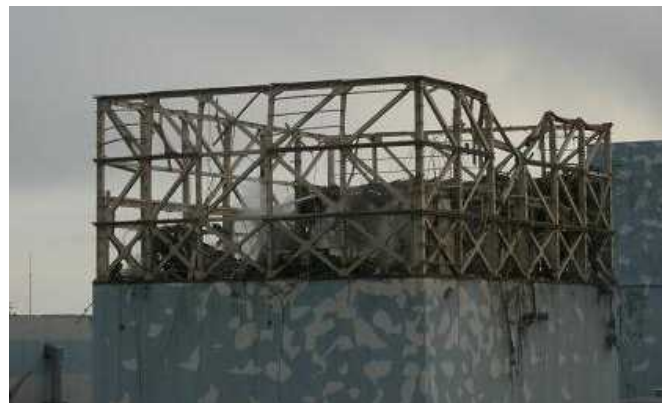
図 1号機原子炉建屋の外観写真
