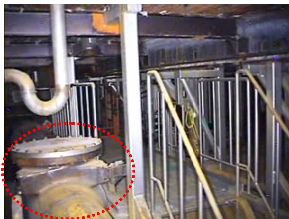
図 2-3 1 号機トーラス室内 S/C 真空破壊弁のカメラ映像（抜粋）
