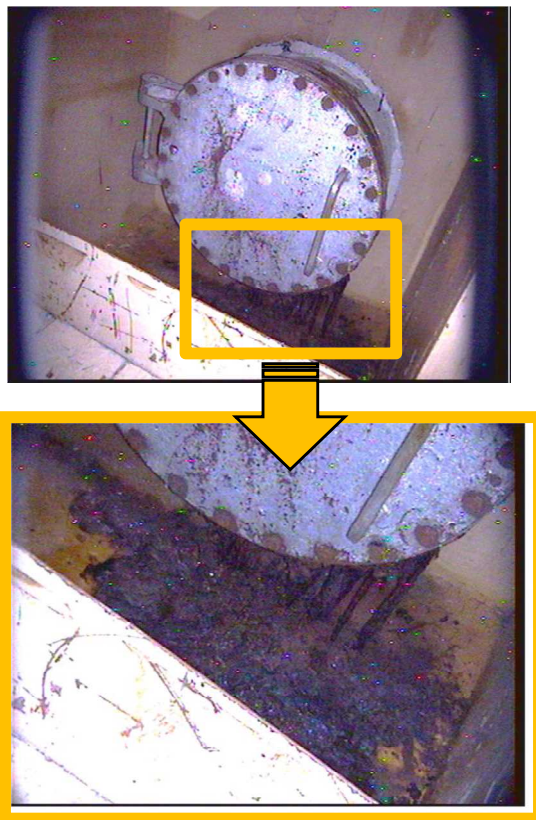
図 3-13 ペネトレーションフランジ部の溶融物の写真[20]
