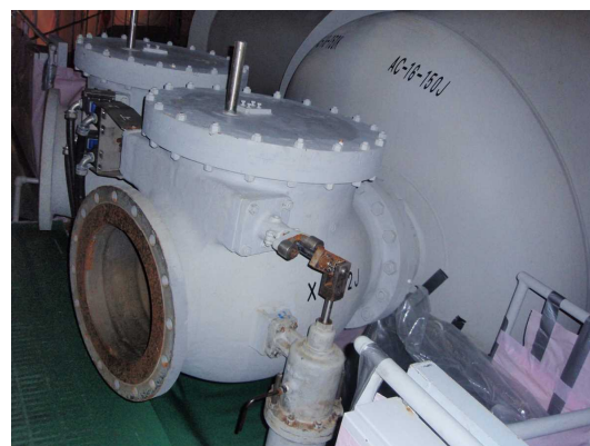
図2 真空破壊弁
