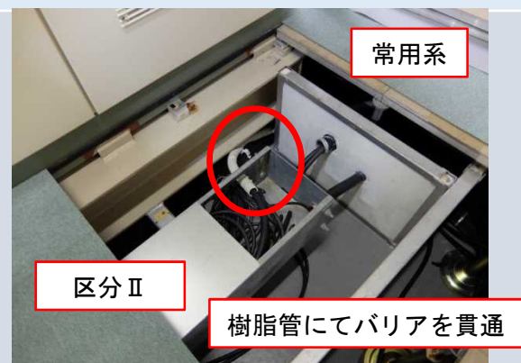
No.9 ②分離バリアを樹脂管で貫通
