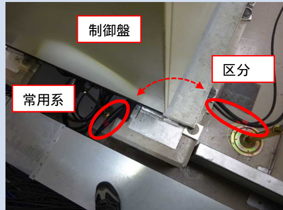
(制御盤による境界)
