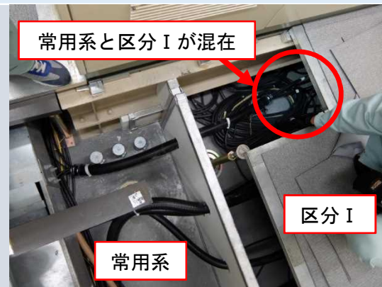
No. 12, 13 ④混在 (異区分のケーブルが混ざっている)
