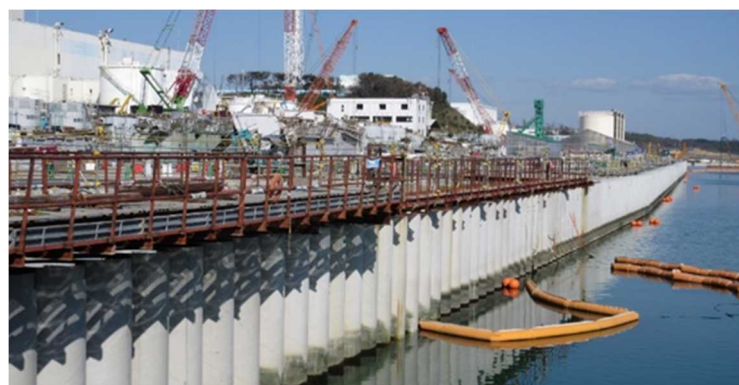
海側遮水壁の閉合
