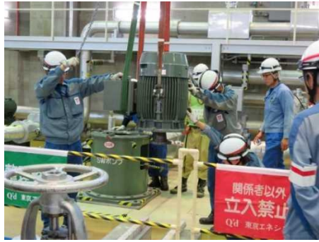
直営による堅型ポンプ用電動機を取替作業
