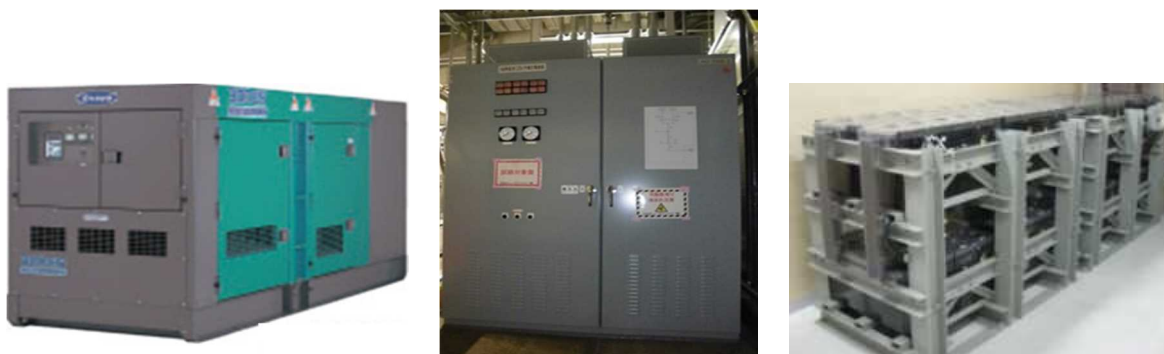
代替直流電源の配備状況（左：充電用発電機、中：充電器盤、右：蓄電池）
