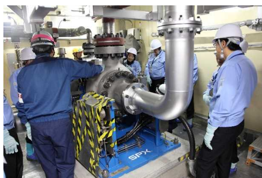
高圧代替注水系ポンプ設置工事の状況(7号機)(右は原子力改革監視委員会による視察状況)
