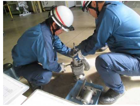
直営による安全弁の分解点検
