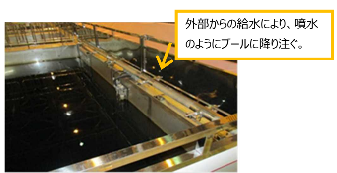
使用済燃料プール外部スプレイ設備
