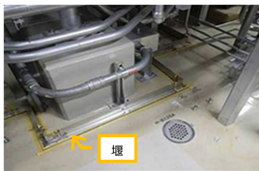
堰（油漏えい拡大防止用）
