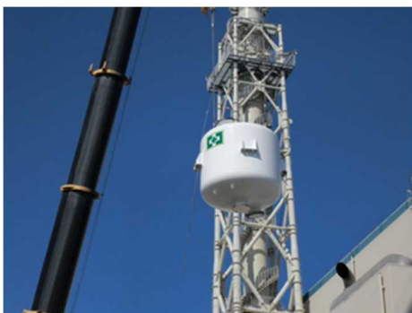
よう素フィルタの搬入・設置 (7号機)
