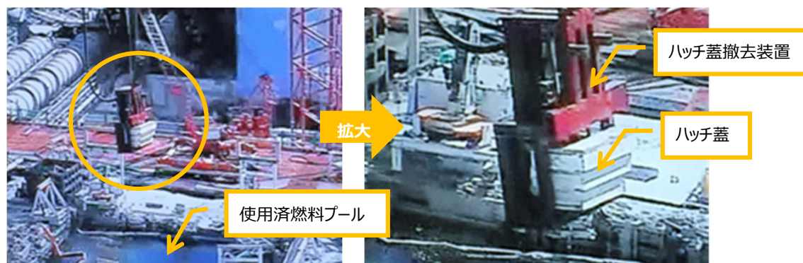
原子炉冷却材浄化系ろ過脱塩器のハッチ蓋撤去作業
