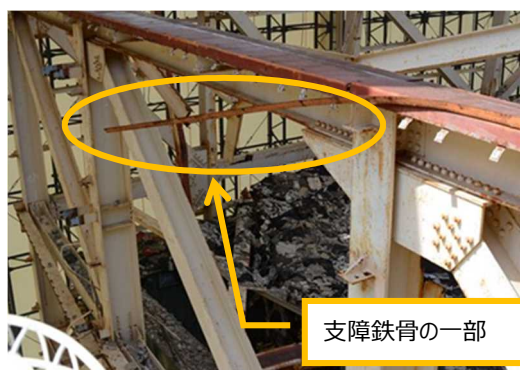
1号機原子炉建屋5階の状態（解体作業上、支障となる鉄骨を確認）
