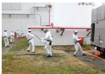
電源車からのケーブル引き出し
