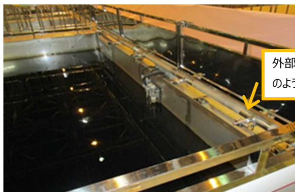
使用済燃料プール外部スプレイ配管の設置状況（6号機）
