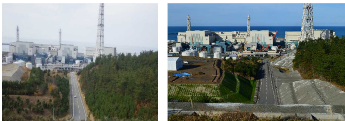
発電所構内（5～7 号機側）における防火帯の状況（左：工事前、右：工事後）
