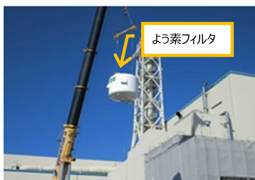
地上式フィルタベント設備の設置状況（7号機）
