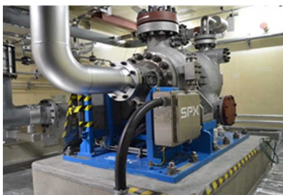
高圧代替注水系ポンプ設置工事の状況(7号機)(右は原子力改革監視委員会による視察状況)
