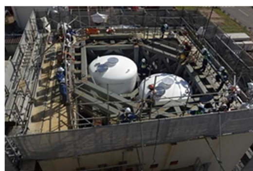
地上式フィルタベント設備の設置状況（7号機）
