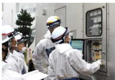
電源車起動後の電圧や周波数の調整
