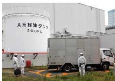
プラント付近までの電源車の運転
