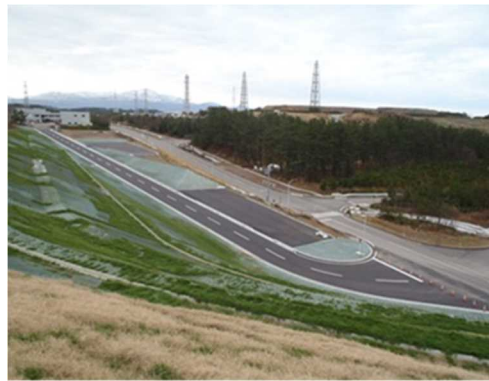
5～7号機の山側に追設したアクセスルート
