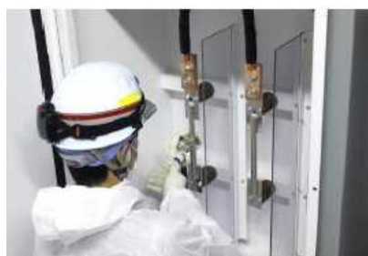
ケーブルの接続
