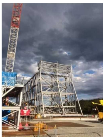
広野町に設置した訓練設備
