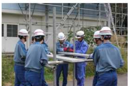
足場の組み立て
