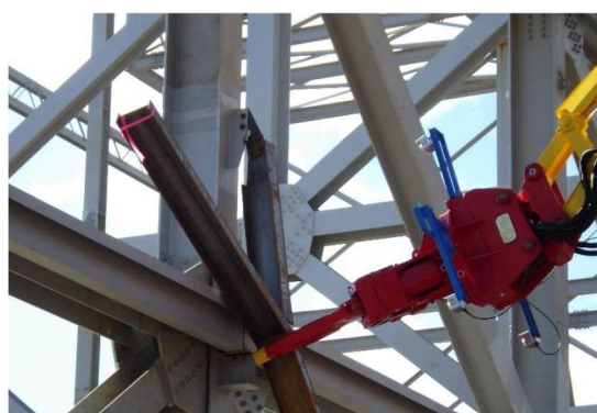
支障鉄骨撤去装置の操作訓練（12月3日開始）
