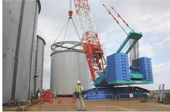
大型クレーンを用いた輸送船へのタンク移動
