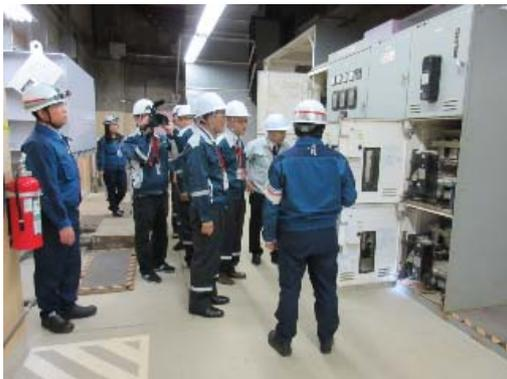
津波により被水した電源盤の確認 (1号機)
