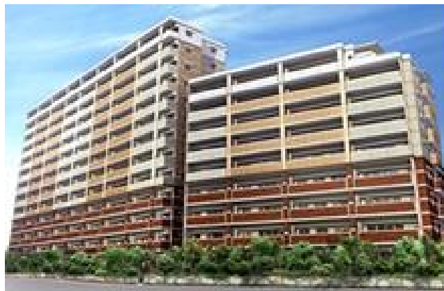
スマートメータが設置されたマンション
