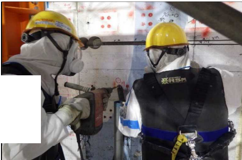
・金物アンカー削孔風景(2)
