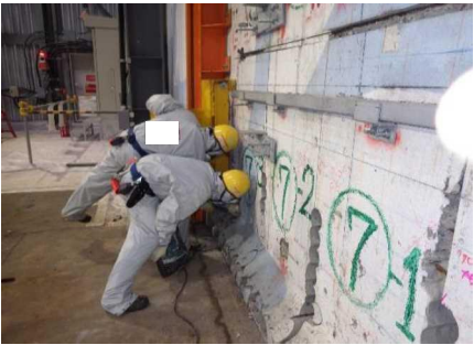
●シャッターレール養生金物取付状況
