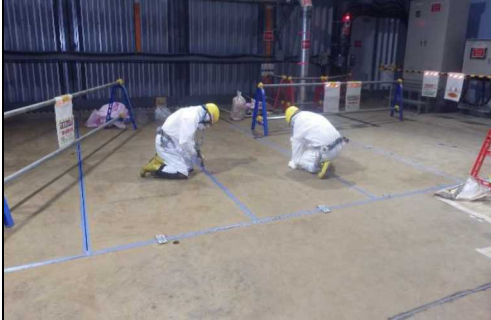
・前室隙間塞ぎ作業風景(2)
