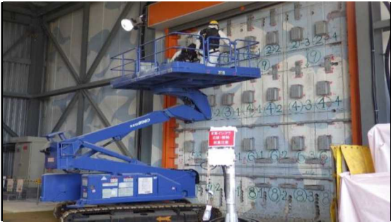
・床鉄板隙間コーキング風景(1)
