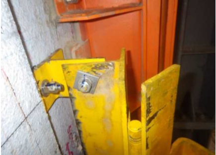
●シャッター養生金物締付ボルト確認
