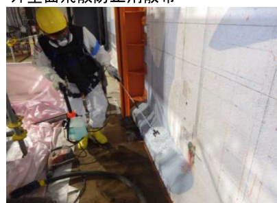
・マシン設置用アンカー打設
