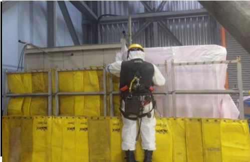
・前室隙間塞ぎ作業風景(2)
