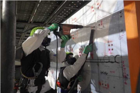
・金物アンカー削孔風景
