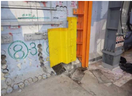
●シャッターレール取付完了写真
