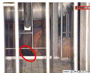
真空破壊ラインベローズ部のベント管側 ベローズカバー部隙間からの漏えいを確認。
