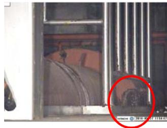
真空破壊ラインベローズ部の真空破壊弁側 固定ボルト用穴部からの漏えいを確認。
