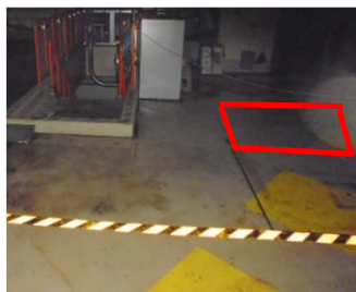
床面 コンクリート塗装面 (水除染済みだが, 固着性汚染のある部位)
