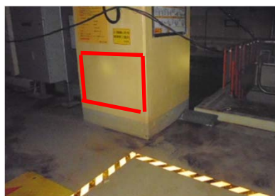
壁面 コンクリート塗装面
