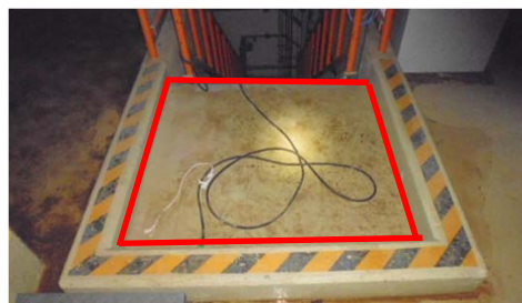
床面 コンクリート塗装面 (未除染)
