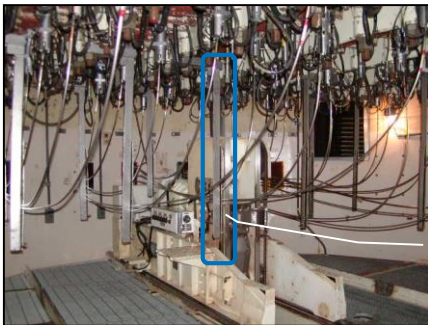
(参考) 2号機のペDESTAL内 定検中写真
