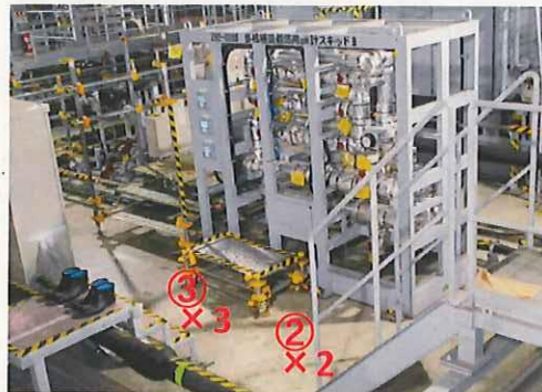
多核種吸着塔用pH計スキッド
