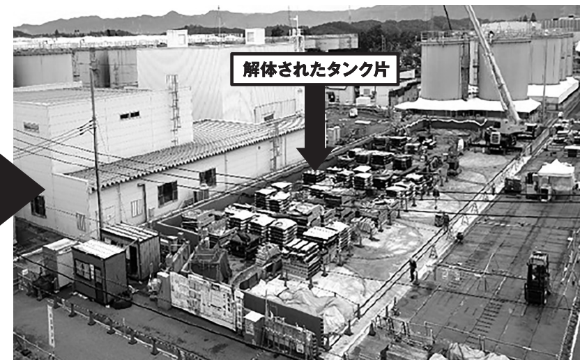
タンク解体後のJ9エリアの様子(撮影日:2025年9月3日)
