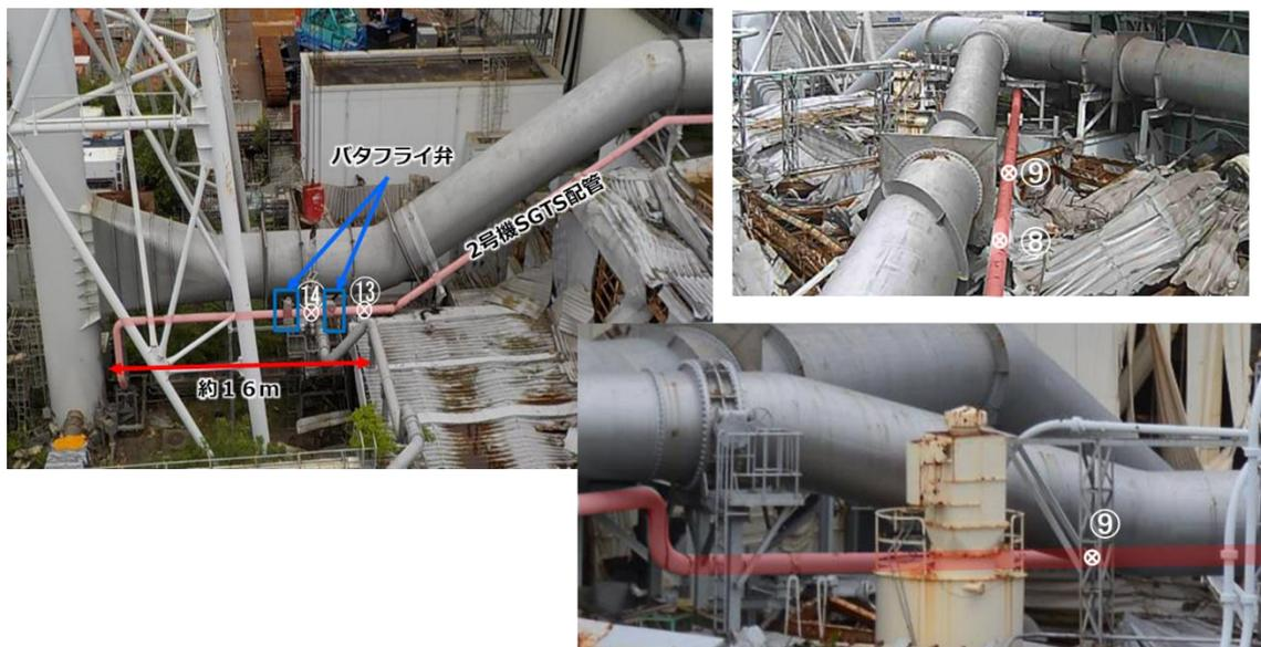
図 2- 44 SGTS 配管近傍で高線量率が確認された箇所
