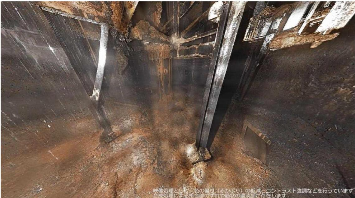
図 3- 43 合成したペDESTAL底部の画像[3-20]
