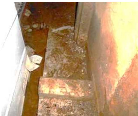
6月5日の現場状況
