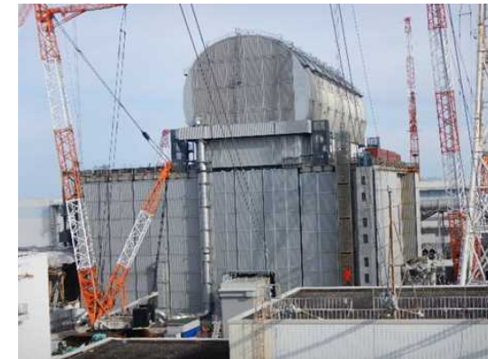
3号機原子炉建屋外観写真の例
