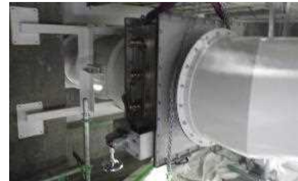
換気・空調設備の工事状況の例
