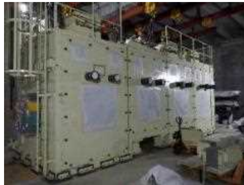
鉄セル本体据付作業状況の例
