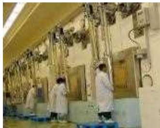
コンクリートセルの例
