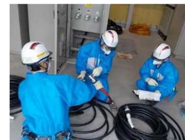
ケーブル導通訓練
