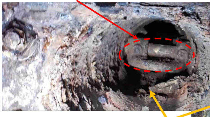
配管内部の状況：堆積物が確認された。
