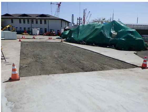
アスファルト舗装はぎ取り（4月15日） （70 \mu m線量当量率が高い箇所）
