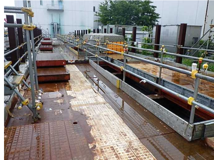
■ 1号機タービン建屋海側 状況写真 (施工前)
