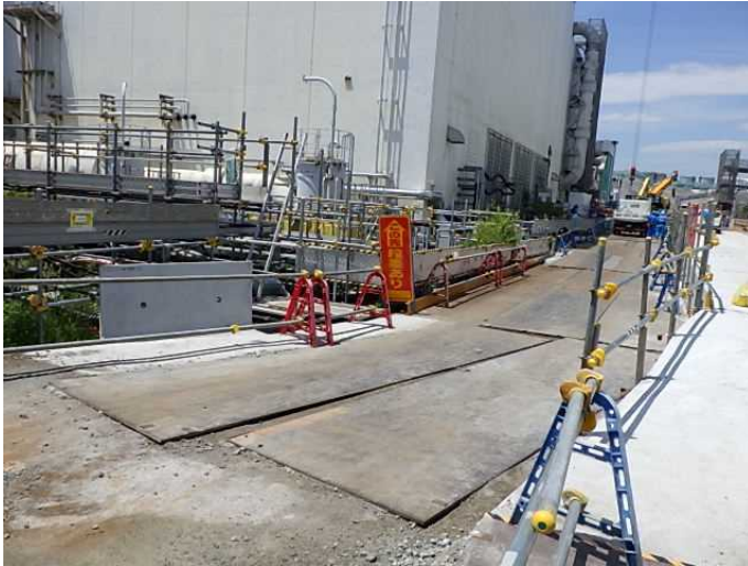
■ 2-3号間道路（海側） 状況写真 (施工中)
