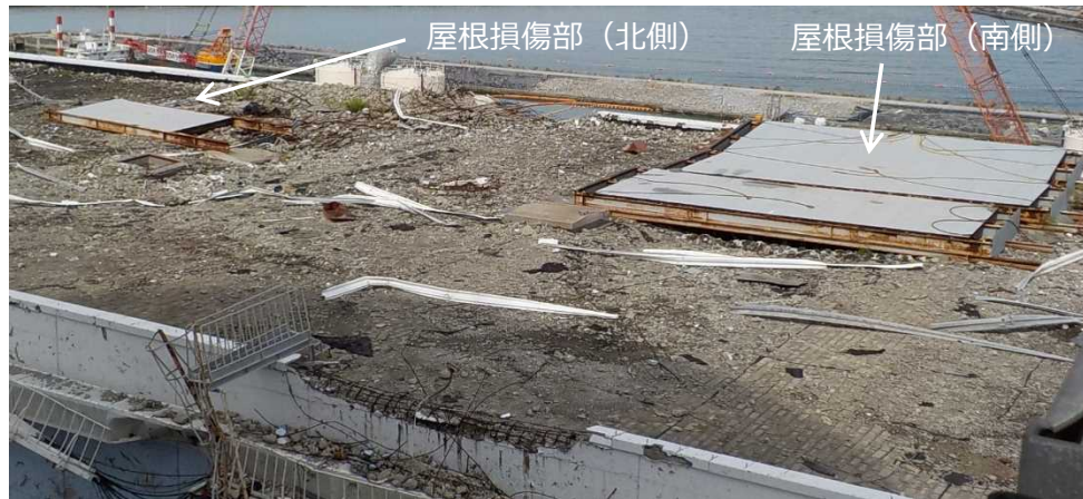
3号機タービン建屋・屋根状況【着手前】 〔西側から撮影〕
